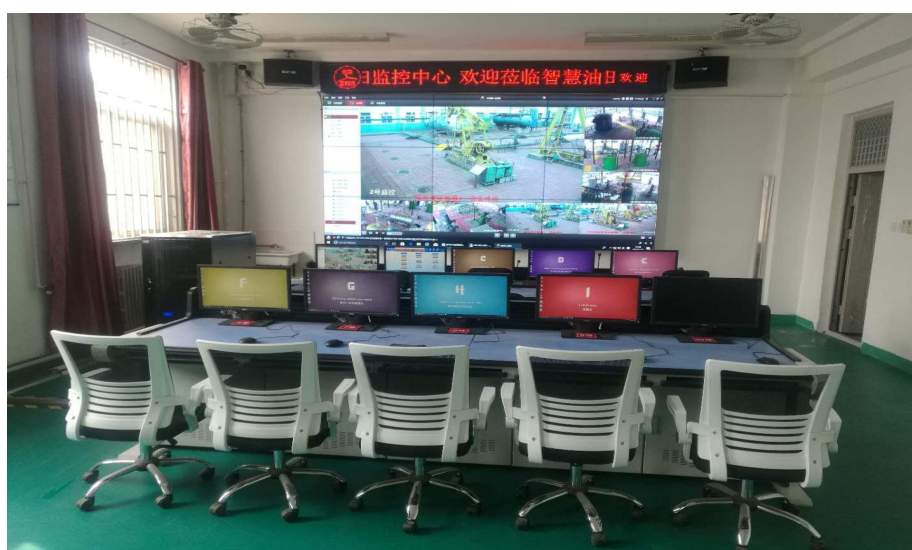
智慧油田生产仿真实训基地中控室
