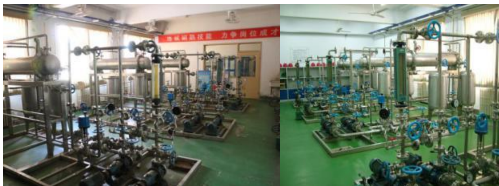
管路拆装实训室
