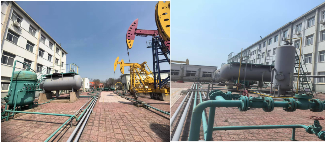
油气储运技能训练场
