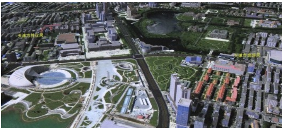
三维城市建设
