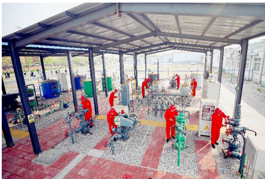
图 1：智慧油田生产一体化实训基地
